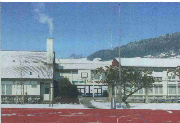
Die Dächer der Oberstufenschule würden sich gut für eine Photovoltaikanlage eignen
