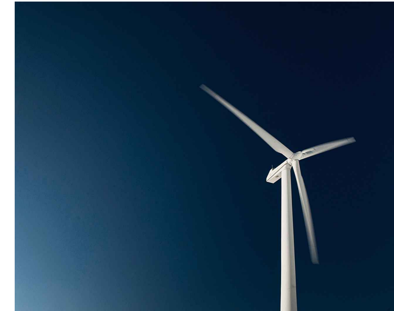
Eine der Windturbinen auf der Rengg bei Entlebuch.
