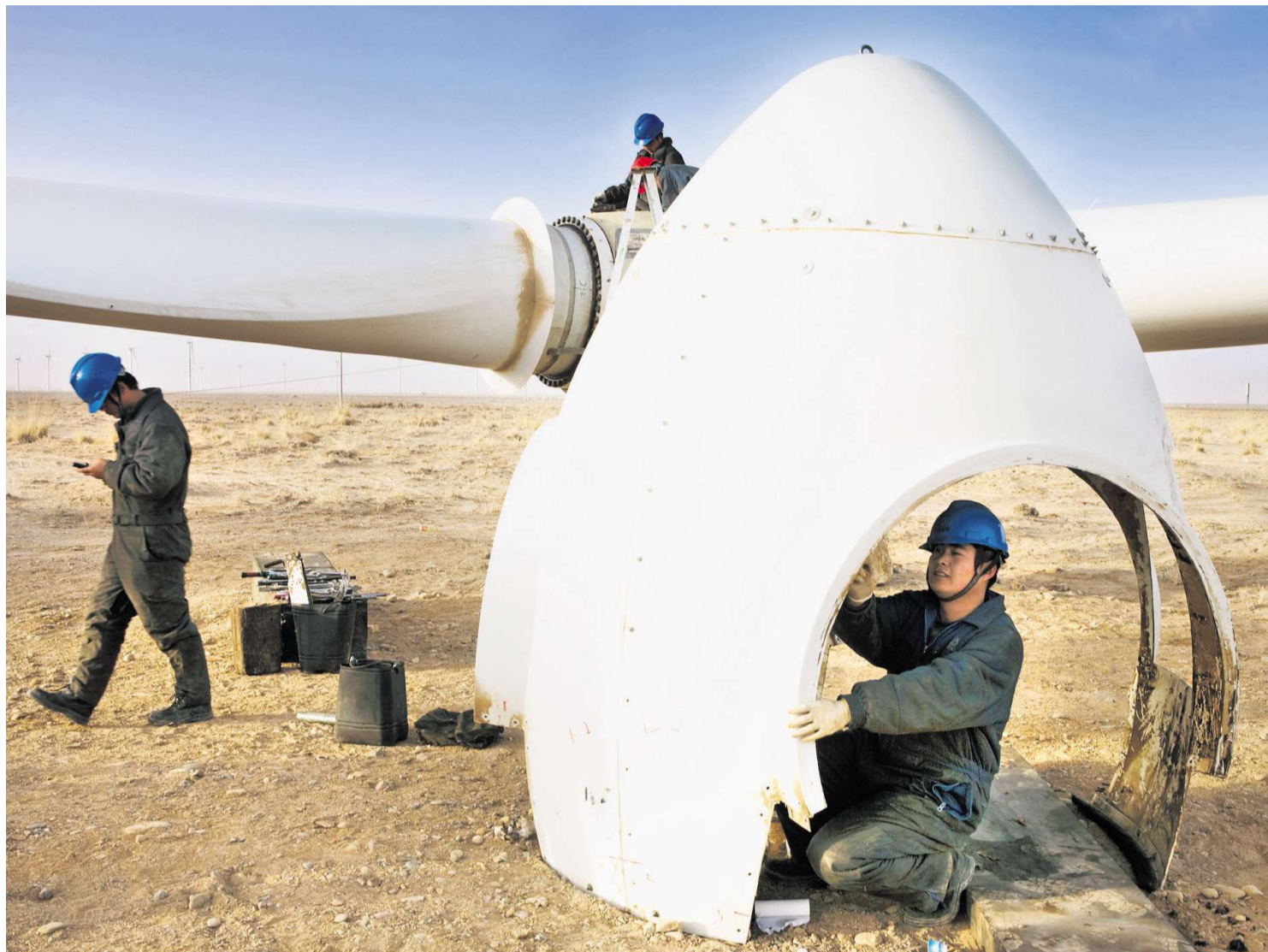
Reparaturarbeiten an einer Windturbine in der chinesischen Provinz Gansu. Foto: Panos Pictures, Visum
