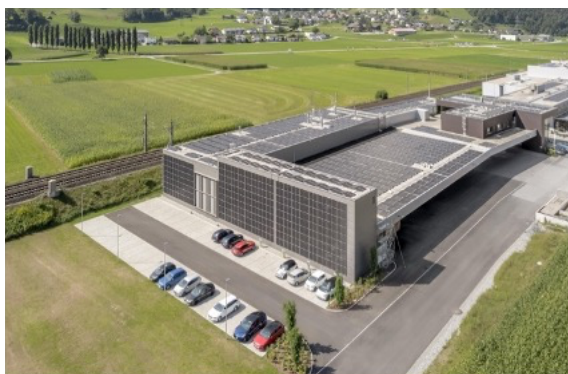
Abbildung 9: Der Produktionsstandort Nenzing des swisscleantech-Mitglieds Griesser ist mit einer Leistung von 700 kW p auf 4'000 m 2 üppig mit PV-Modulen ausgestattet.
