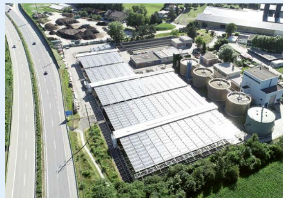
Le toit solaire rétractable de dhp technology peut être déployé au-dessus de surfaces déjà occupées et s'ouvrir et se refermer automatiquement.
